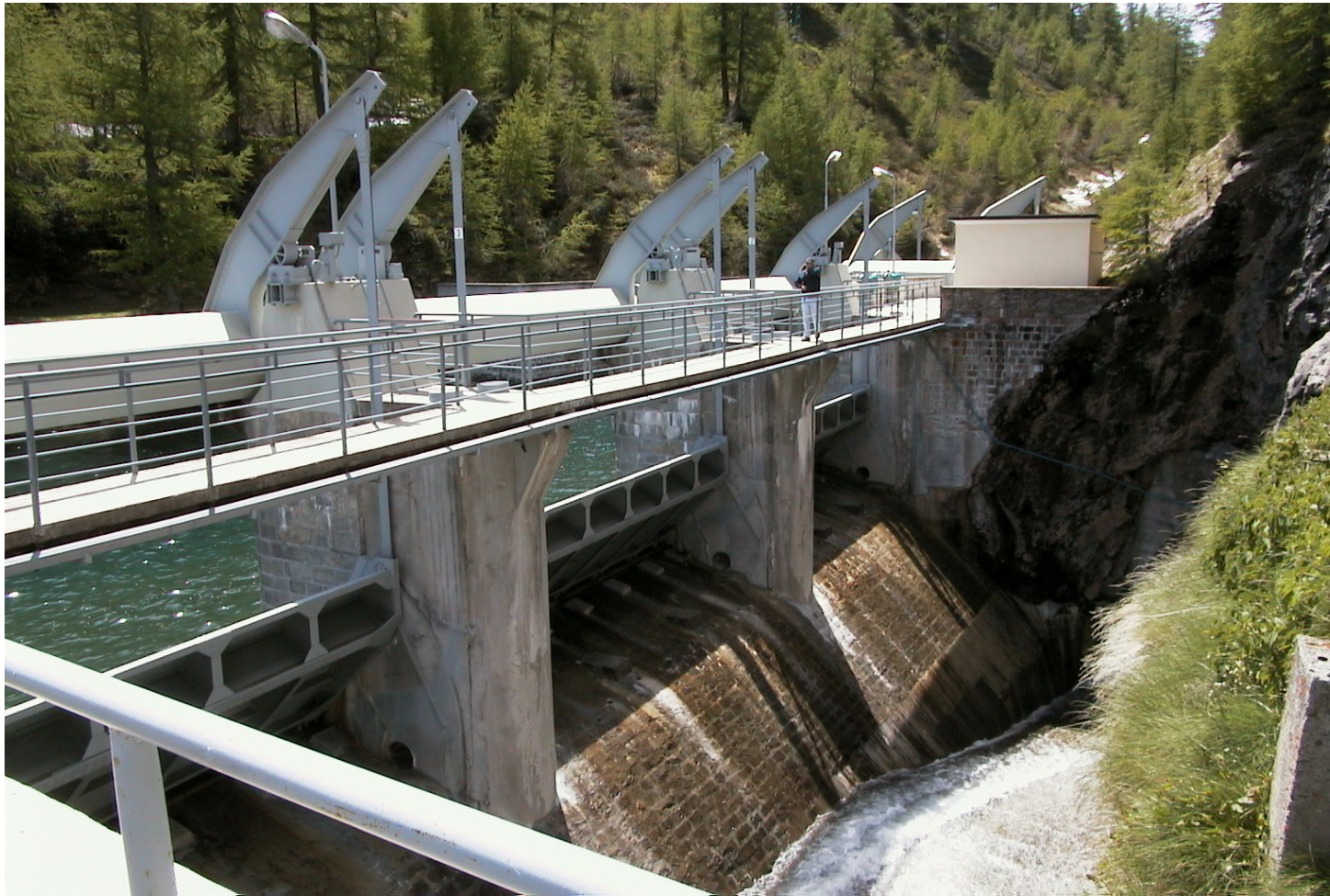
PARATOIE A VENTOLA TRACIMABILI - Diga di Devero-Codelago (VB) - larghezza: 8,50m ciascuna; altezza: 2,10m; Portata massima evacuabile: 210 m 3 /s
