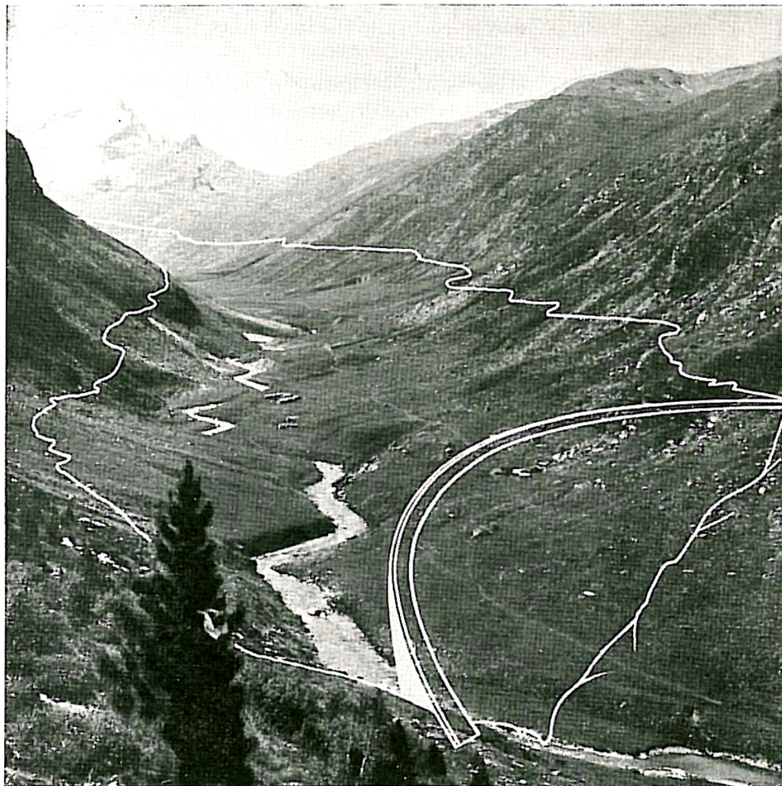
Fig. 402 – Aspetto di una zona d'invaso prima della costruzione della diga. Quest'ultima è indicata in bianco sulla destra. La linea bianca sui fianchi della valle indica il livello di massimo invaso (Valle del Reno di Lei).
