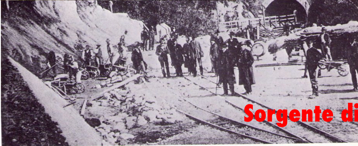
Caposele. Lavori dell'Acquedotto Pugliese. Imbocco Galleria dell'Appennino.
