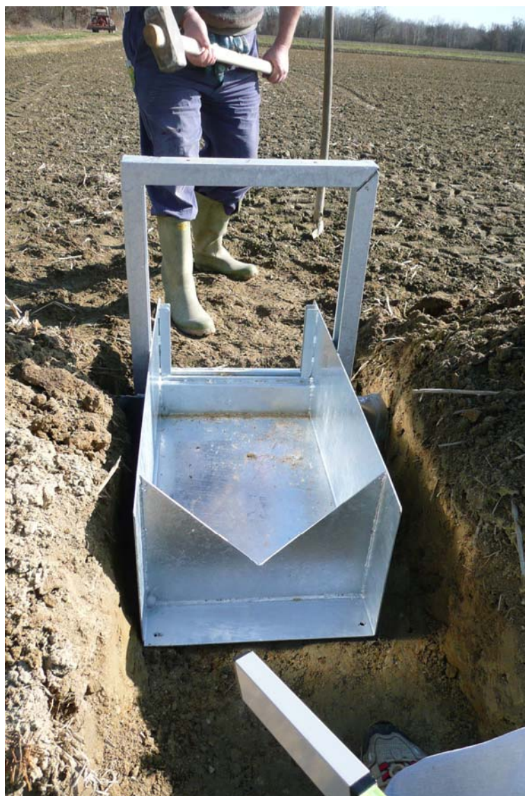
Figura 9.8: Installazione di una sezione in lamiera per il monitoraggio delle portate.
