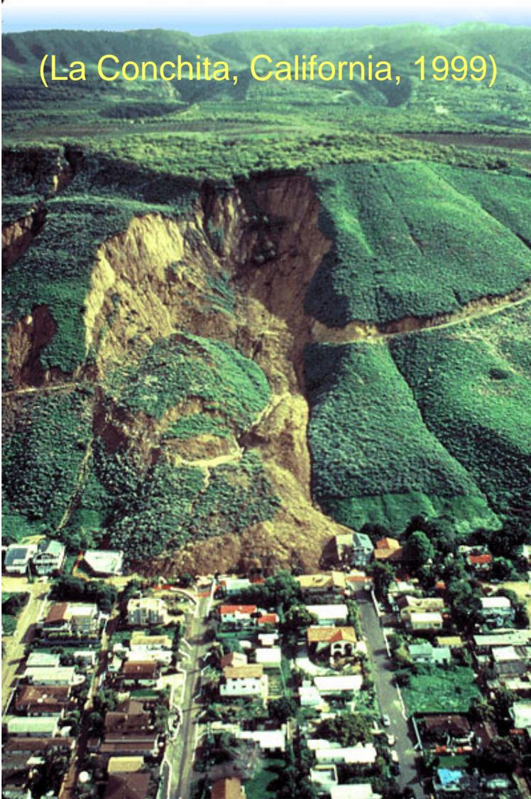
La pioggia s'infiltra nel terreno ed incrementa il livello della falda profonda. La relazione tra l'intensità e la durata della pioggia e la stabilità del pendio non è sempre facilmente determinabile.
