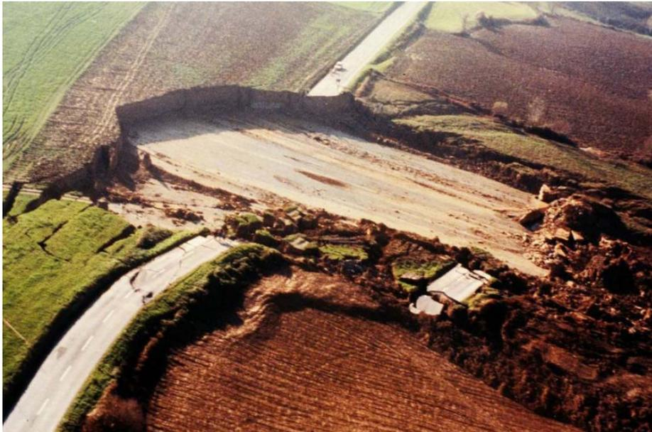
Alternanze di marne e arenarie. Scivolamento su un livello di marna costituito da argille rigonfianti.
