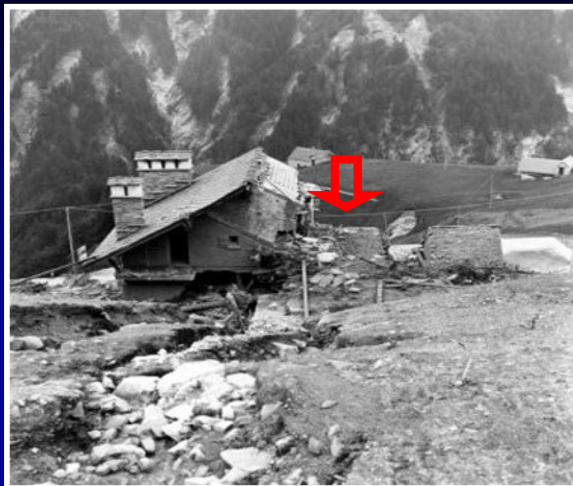
Edificio parzialmente travolto e distrutto da una piccola frana nel bacino del Torrente Melezio Orientale, con perdita di una vita umana (agosto 1978, foto C.N.R.-I.R.P.I.).
