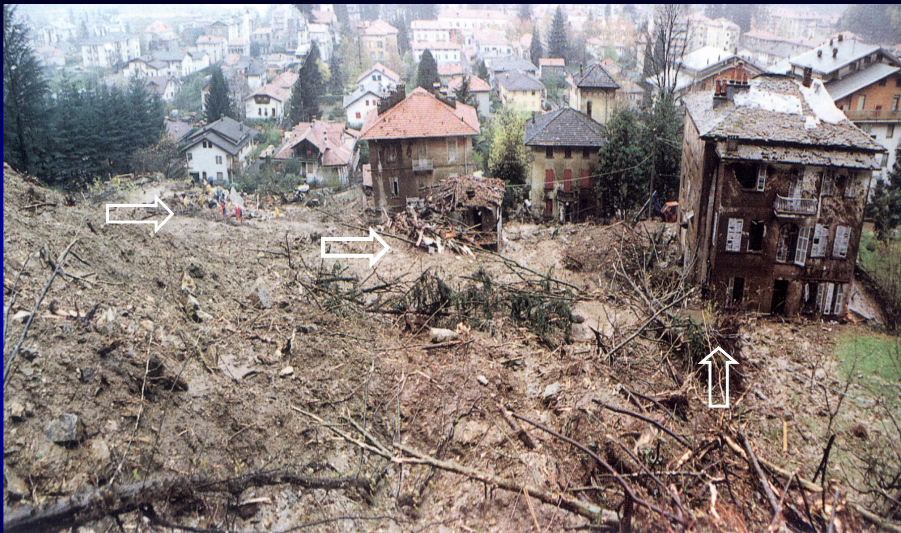
Frana di Varallo Sesia che ha provocato la distruzione di due edifici, la morte di 14 persone e il ferimento di altre 3 (Evento alluvionale del Novembre 1994)
